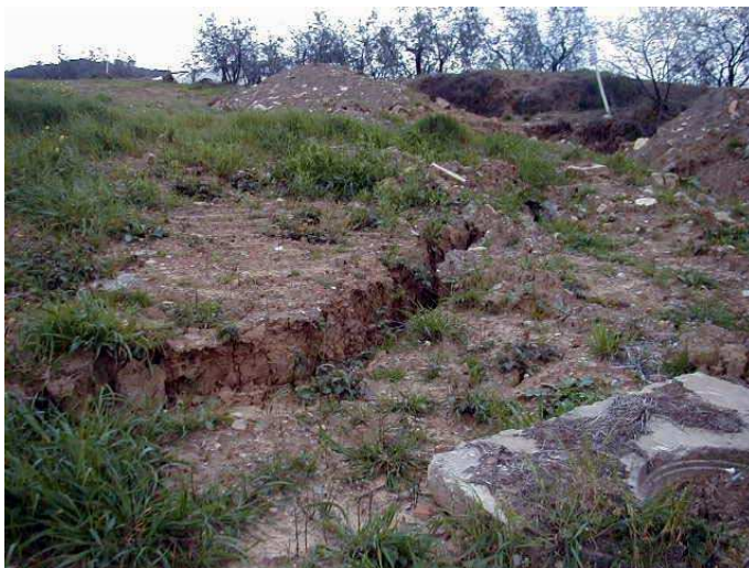
Foto 8 : Frana indotta da attività connessa alla sistemazione di una sorgente
