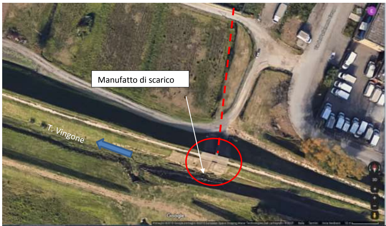
Figura 6 - Manufatto di scarico sul T. Vingone
