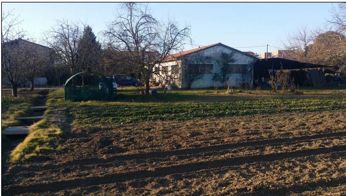
Foto 1 Vista dell'area di intervento e dell'edificio esistente da via del Pellicino.
