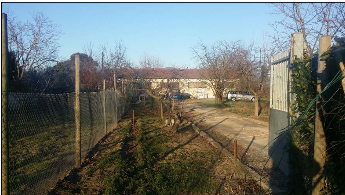
Foto 2 Vista dell'area di intervento e dell'edificio esistente da via del Pellicino.
