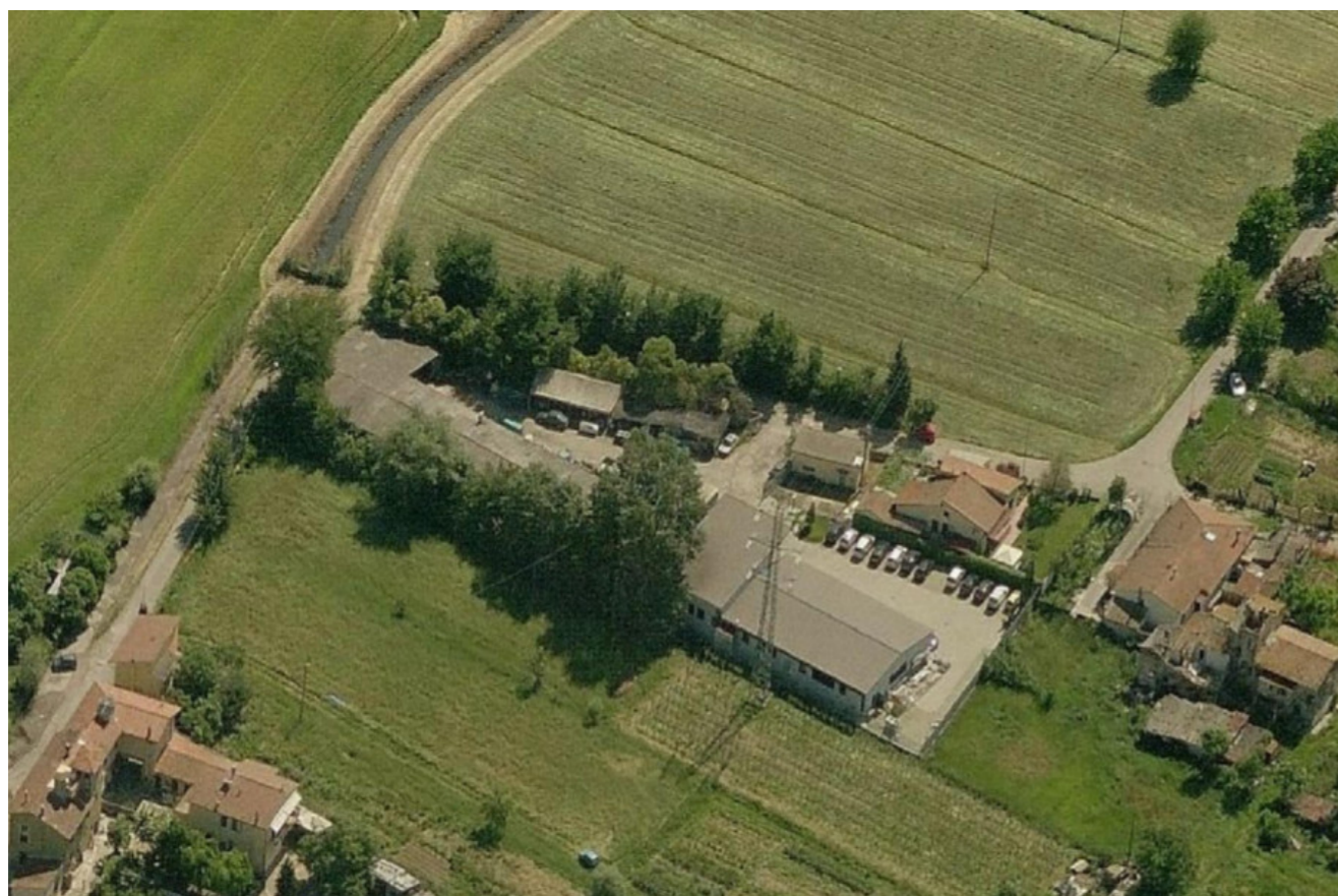
VISTA D'INSIEME DA NORD
