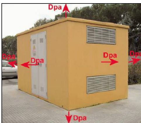
Figura 56. Esempio di distanza di prima approssimazione (dpa)
