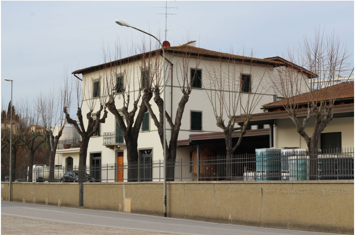
EDIFICIO CANTINA BORGHINI MARIO
