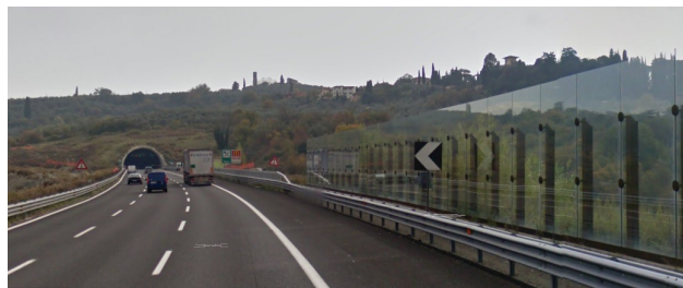
Barriera fonoassorbente – Autostrada A1
