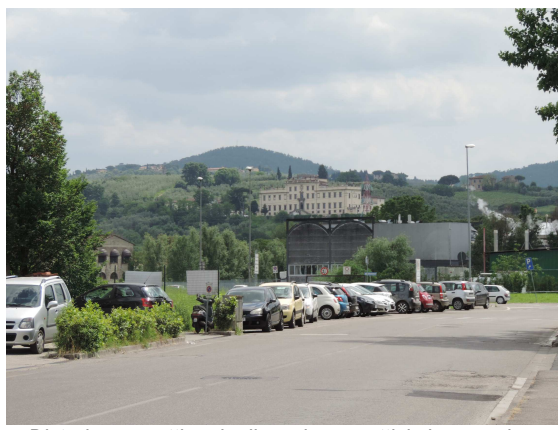
Disturbo percettivo degli assi prospettici che guardano verso la collina in zona produttiva prive di impianto preordinato e con edifici di scarsa qualità architettonica
