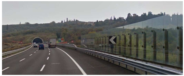
Barriera fonoassorbente – Autostrada A1
