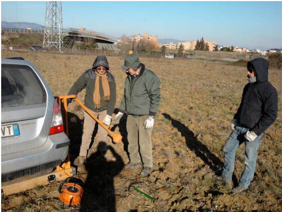
Shot Point E - onde SH – ST6
