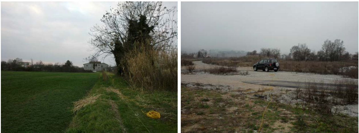
Figura 1: Particolare delle linee elettriche: sezione elettrica ST1 (sinistra); sezione elettrica ST4 (destra).
