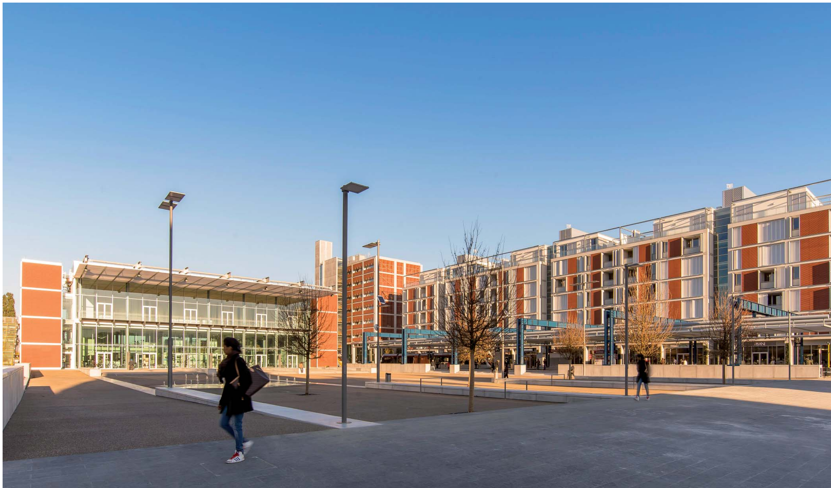
Il Nuovo Centro Civico recentemente completato
