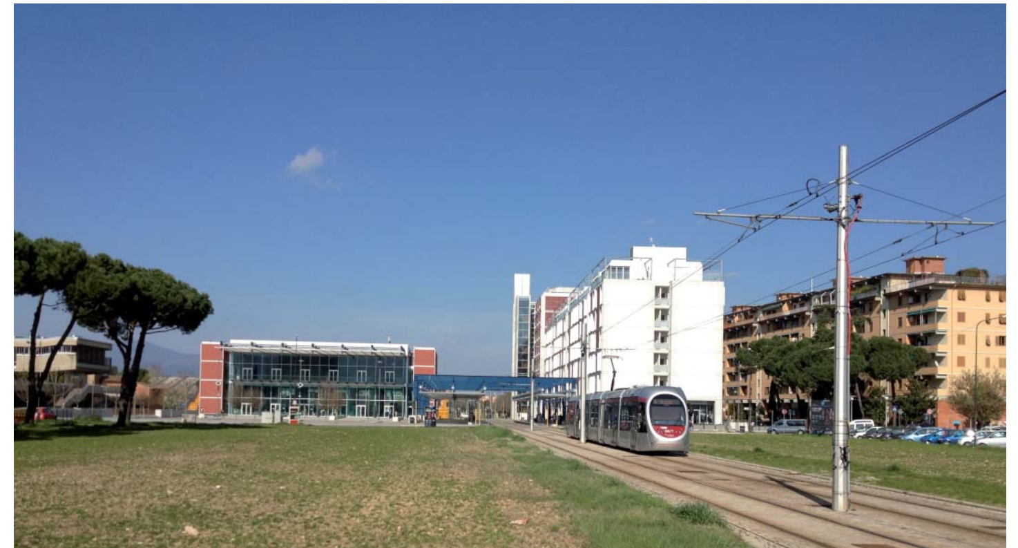
Vista dell'area verso la Piazza
